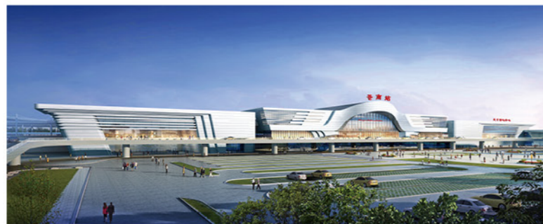
杭深铁路·苍南站
