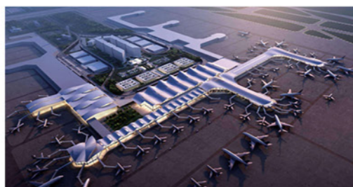
浙江·杭州·萧山国际机场三期
