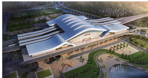
杭绍台城际铁路
